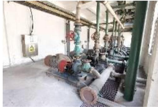
(1) 传输泵密封良好；且各传输泵地面为硬化地面；
