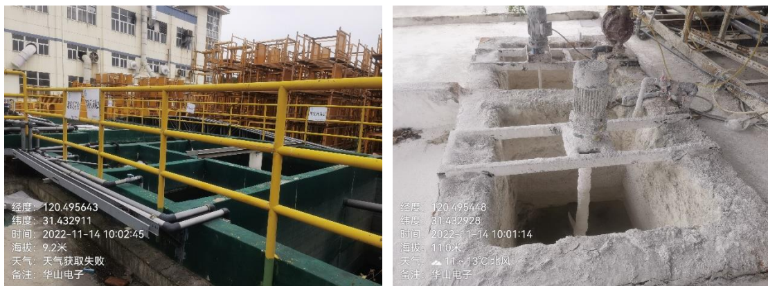
图4.1-2 反应及储存池体
