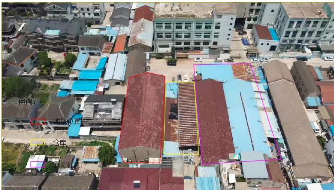
地块东侧（塑料管仓库、宏发机械厂）
