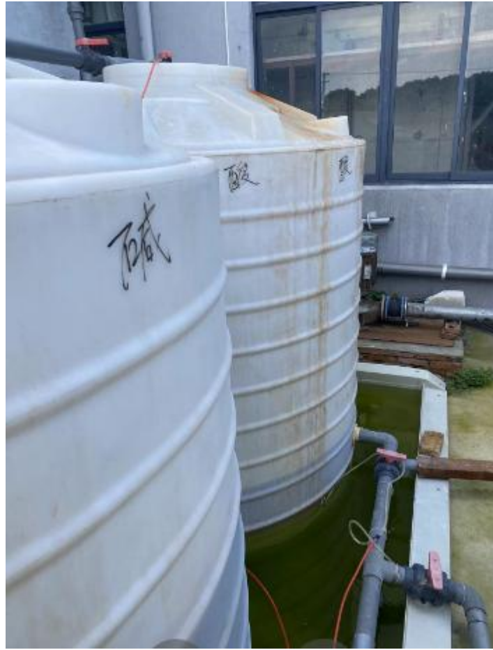
图4.1-3 生产废水管道（地上）
